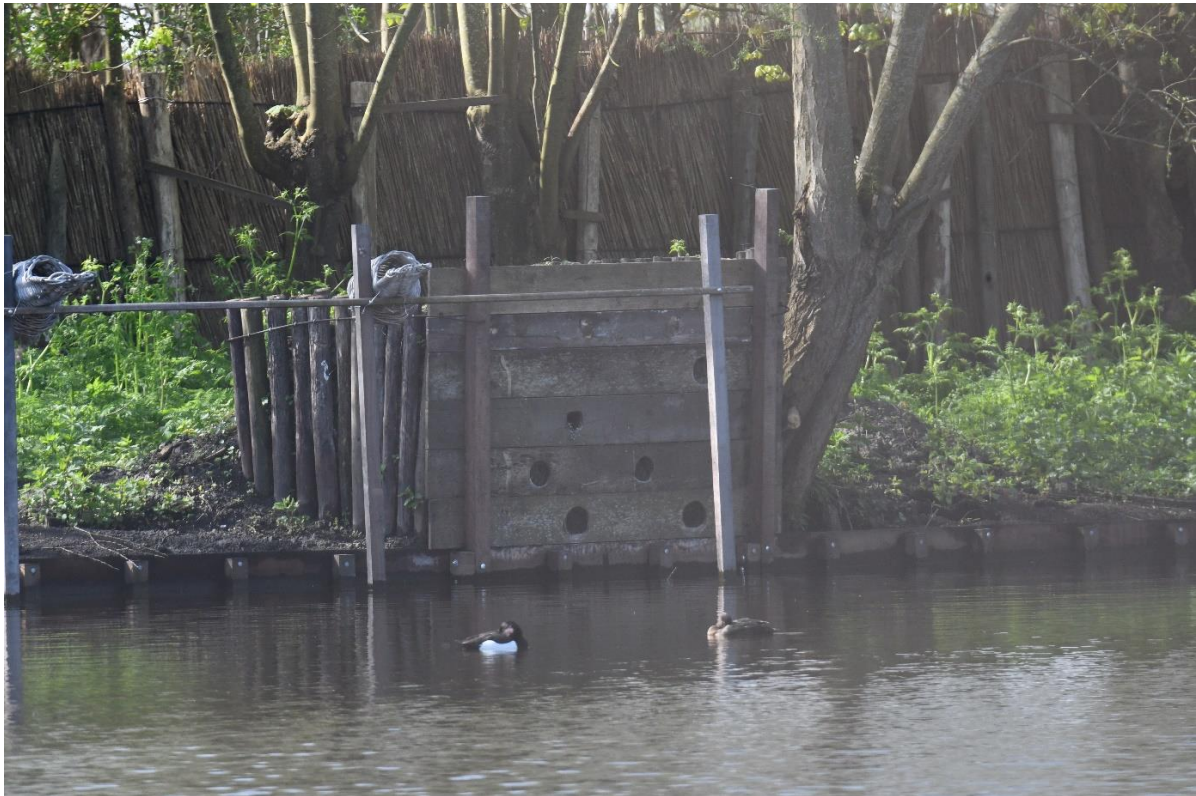
Figuur 2 - IJsvogelwand na de verbeteringen (april 2023)
